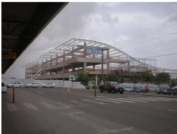
Figura 49: Novo terminal de Macapá sendo construído
